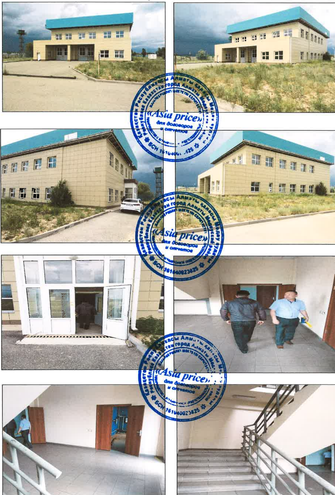
Общий вид здания
