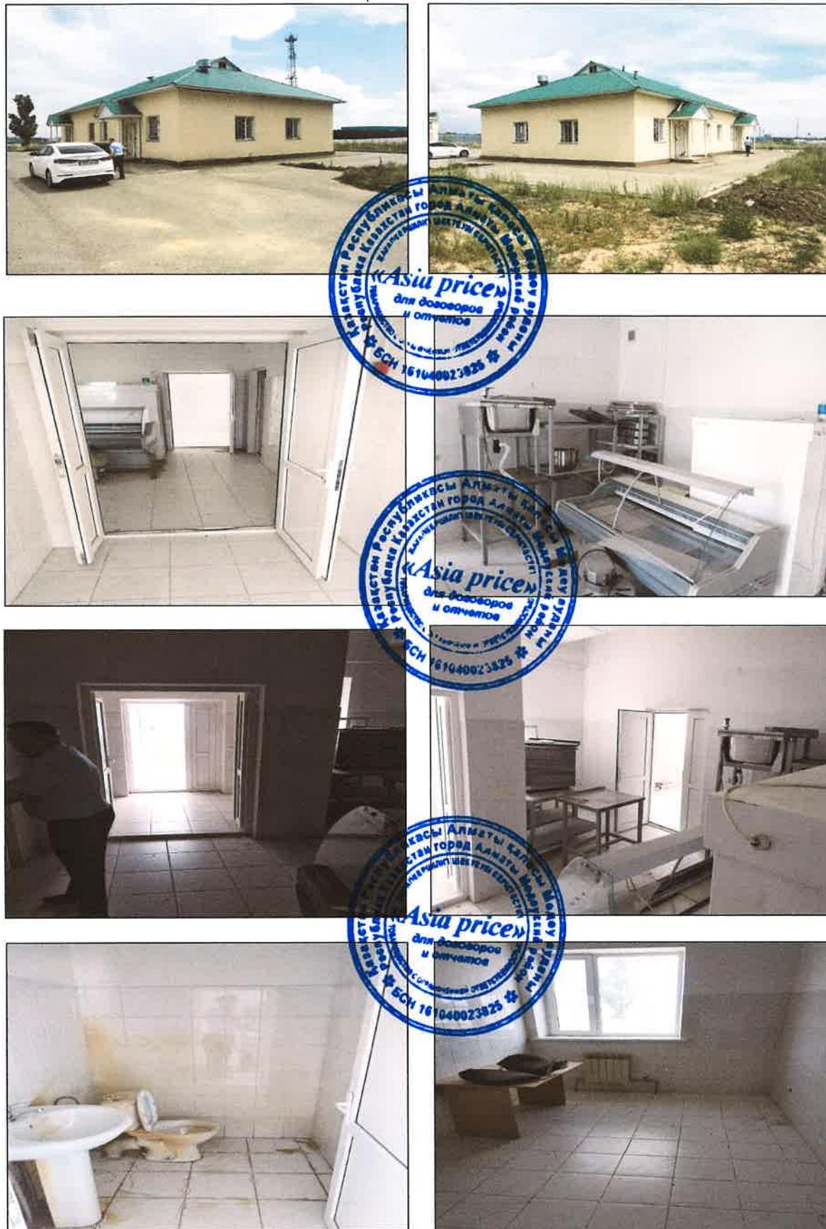
Общий вид здания
